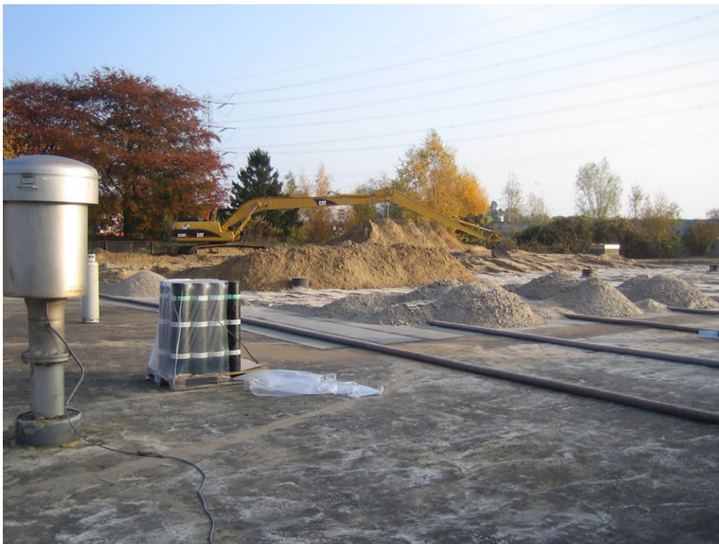
Foto 15 Dak van een reservoir bestaande uit dakbedekking (zand en grond moeten nog worden aangebracht) (foto Vitens).
