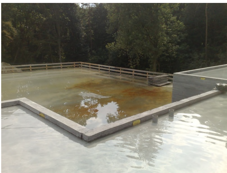
Foto 16 Testen waterdichtheid van het dak van een drinkwaterreservoir (foto Evides Waterbedrijf).
