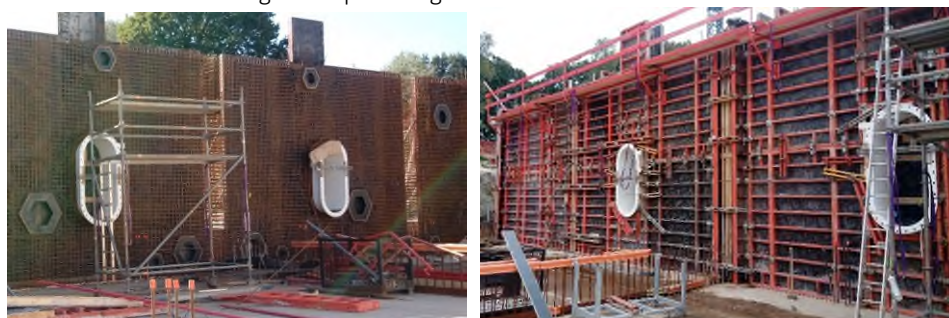
Foto 13 Wand van een drinkwaterreservoir in aanbouw, voor én na sluiting van de systeembekisting. Zowel rechtstreeks in te storten doorvoeren (witte ovale mangaten) als bekistingen voor sparingen zijn toegepast (foto's Pidpa).
