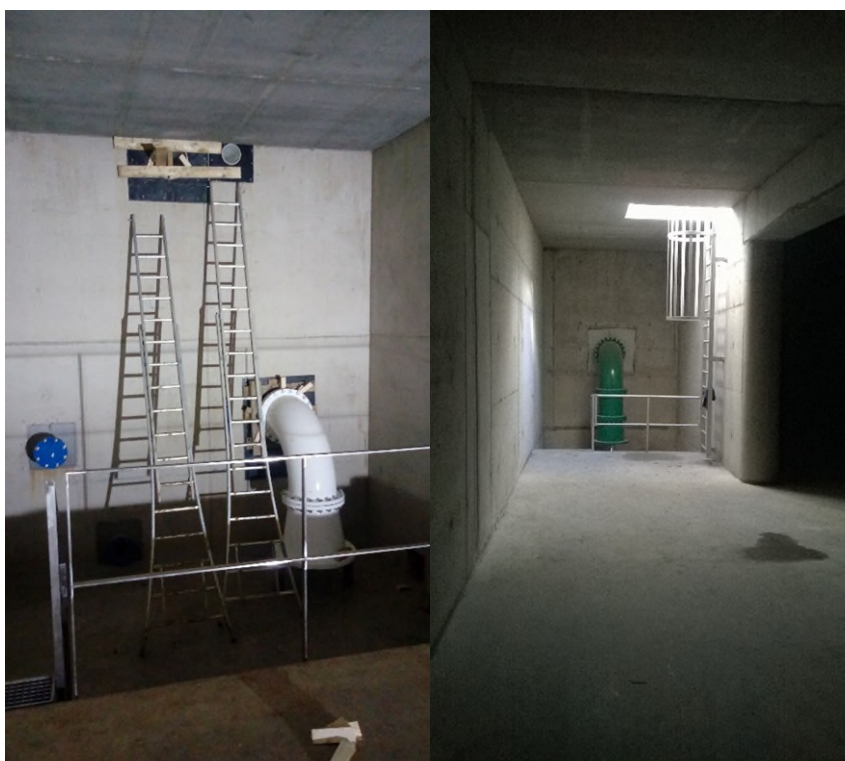
Foto 8 Zuigkuil in aanbouw (links) en afgewerkt (rechts) (foto's Pidpa).
