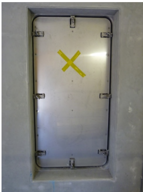
Foto 3 Waterdichte deur in een reservoir (foto Vitens).
