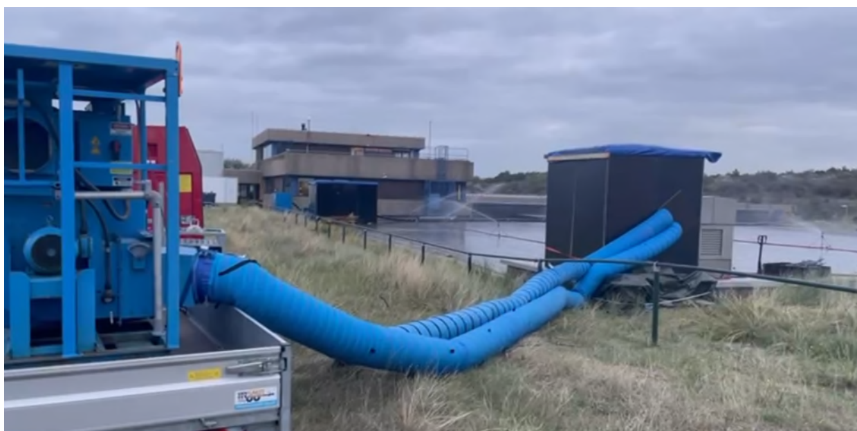
Foto 17 Toegangsvoorziening tijdens onderhoud boven het luik van een aangeaarde kelder (foto PWN). Tevens zijn hier het uitwendig natspuiten van de constructie en inwendig drogen toegepast om lekkages te kunnen identificeren.
