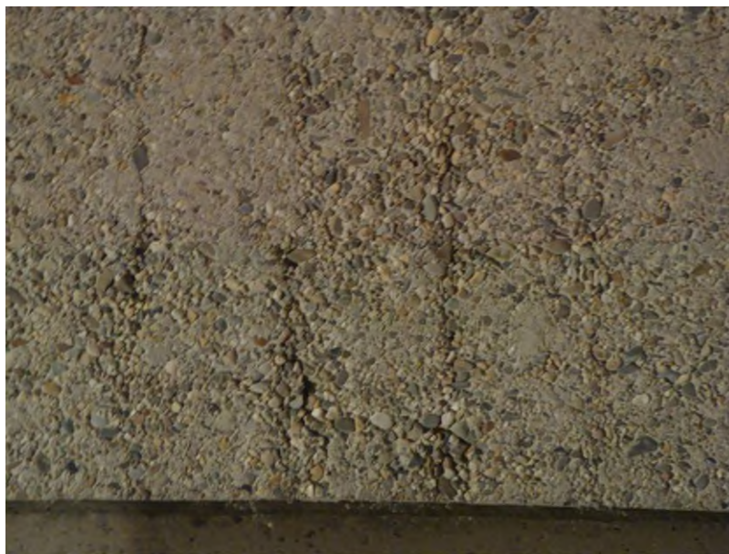
Foto 24 Oppervlakteruwheid beton.
