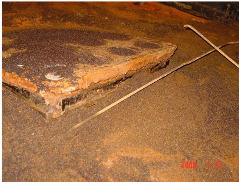
Foto 26 Beschadigde filterbodem.
