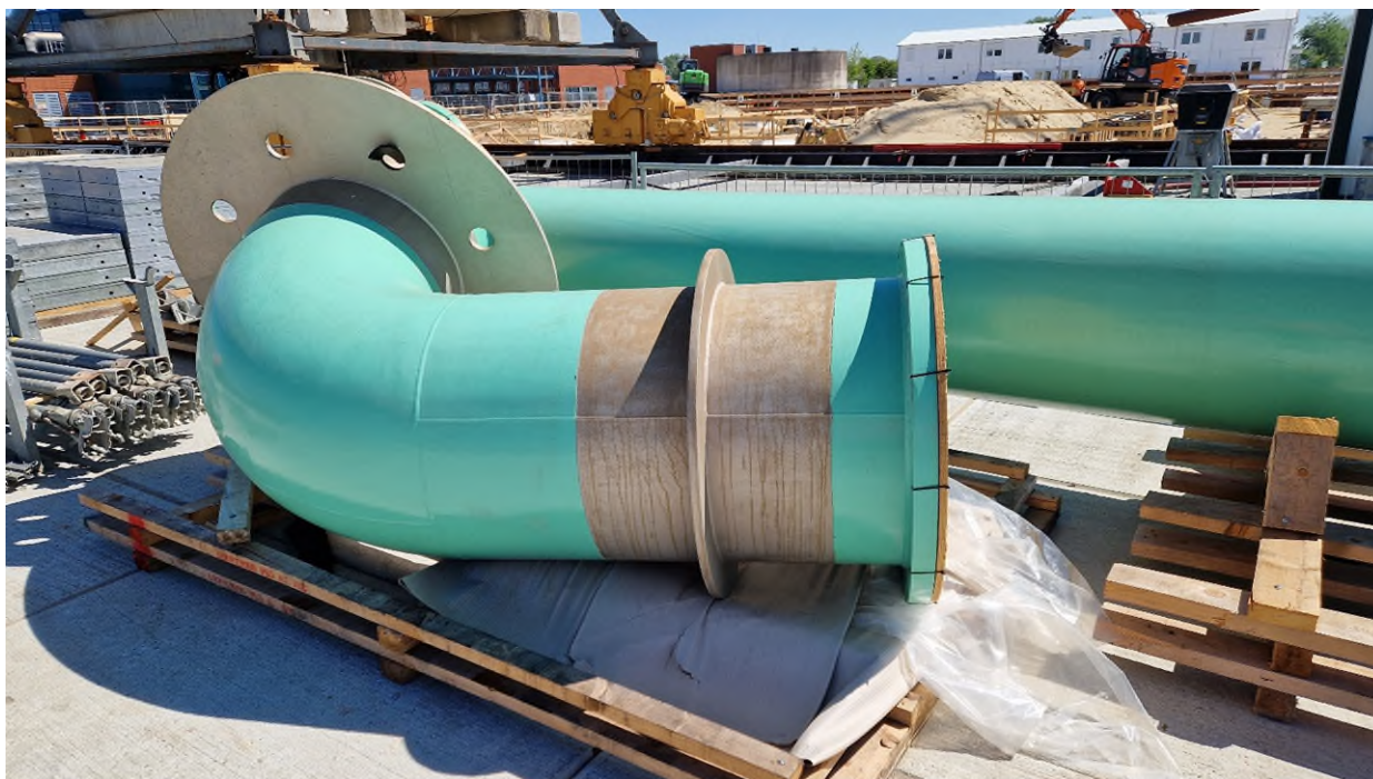
Foto 12 Nog in te storten doorvoerstukken op de bouwterrein. Het niet-gecoate deel aan de buitenkant is zichtbaar (foto PWN).
