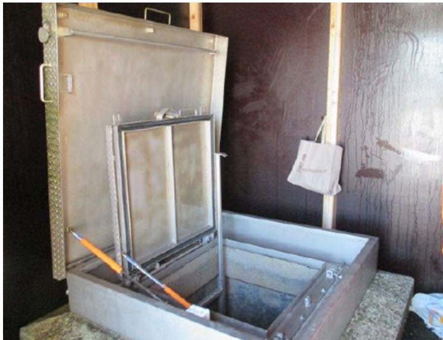
Foto 1 Voorbeeld van een primair luik voorzien van een secundair luik als inbraakschil, inclusief detectie en slot (foto drinkwaterbedrijf).
