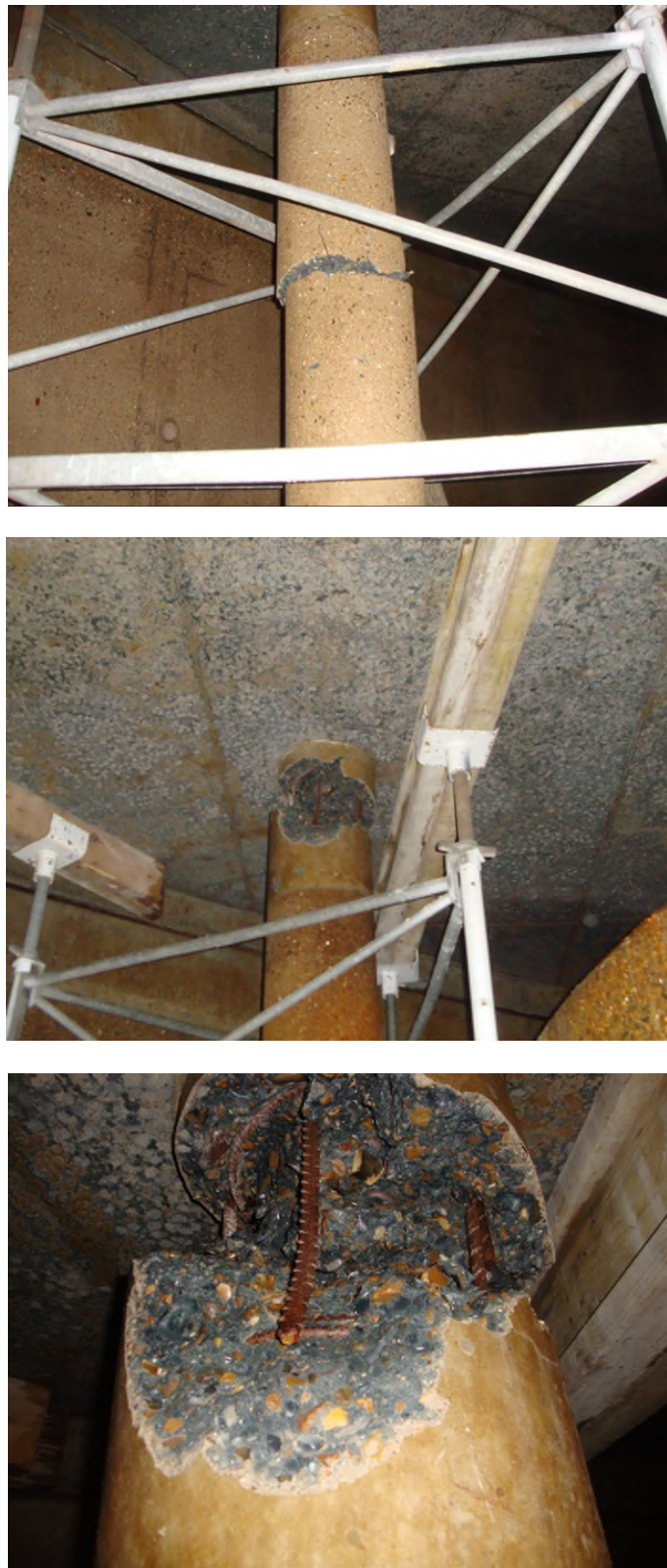
Foto 10 De gevolgen van het opdrukken van het dak van een reservoir (foto's PWN).
